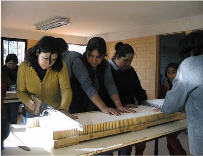
El trozo de pluma vit es rígido, por tanto hay que darle flexibilidad para curvarlo. Ello se logra haciendo varios cortes en el sentido del ancho con una profundidad del 75% del espesor. Para guiar los cortes es necesario hacer una plantilla, que vamos a detallar a continuación.
