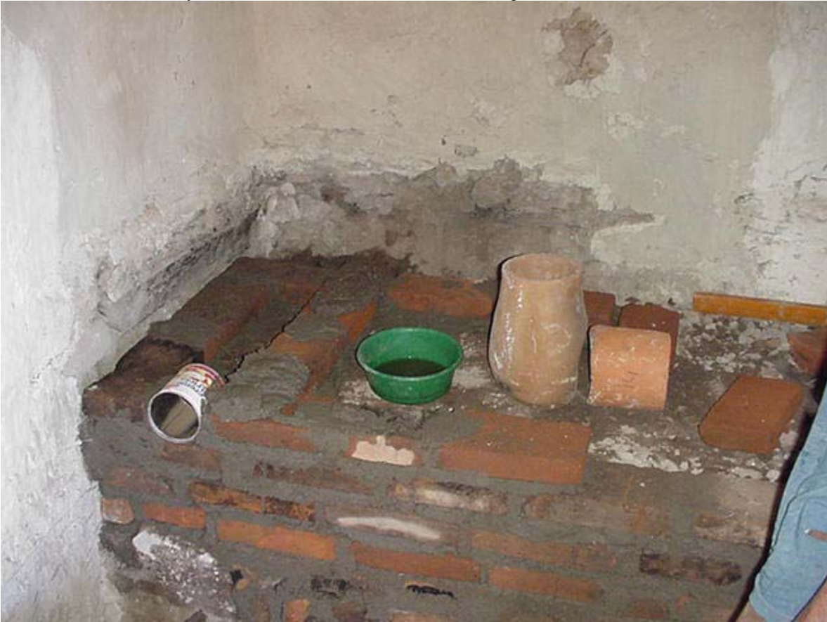
A space in the third row of bricks for the smoke to escape to the chimney. Un espacio en la tercera línea para que el humo escape hacia la chimenea
