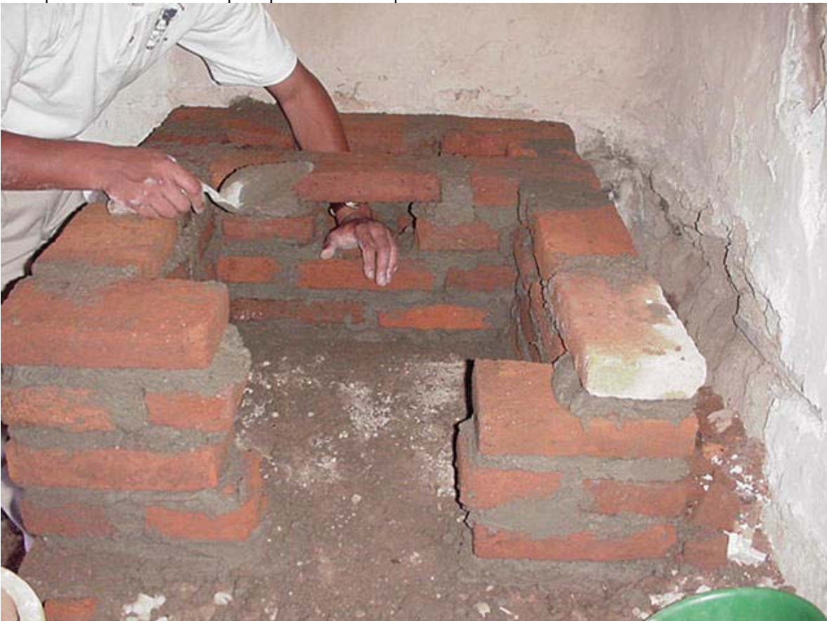
A space in the third row of bricks for the smoke to escape to the chimney. Un espacio en la tercera línea para que el humo escape hacia la chimenea
