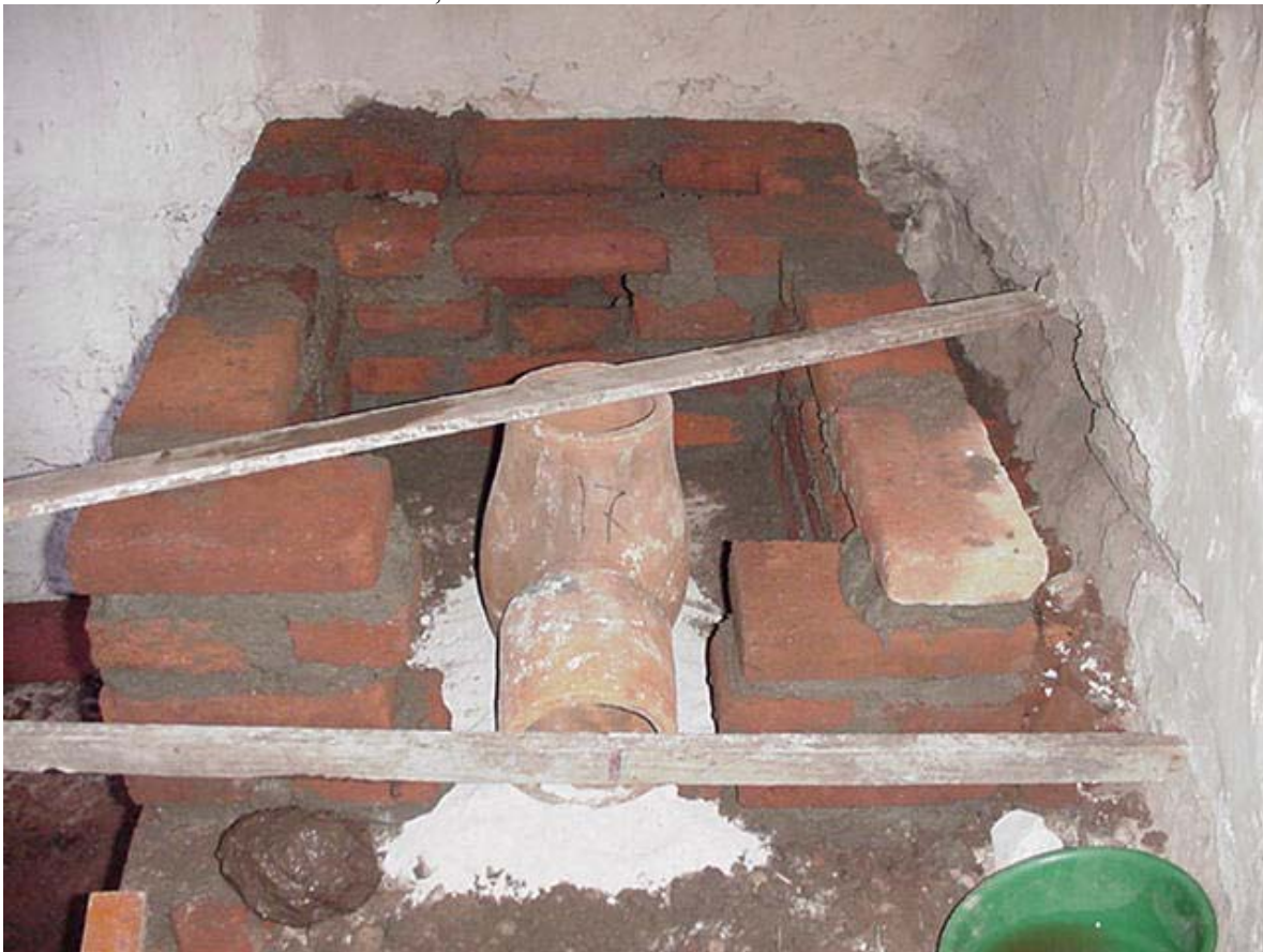
Sealing the elbow with mud Sellando el codo con lodo
