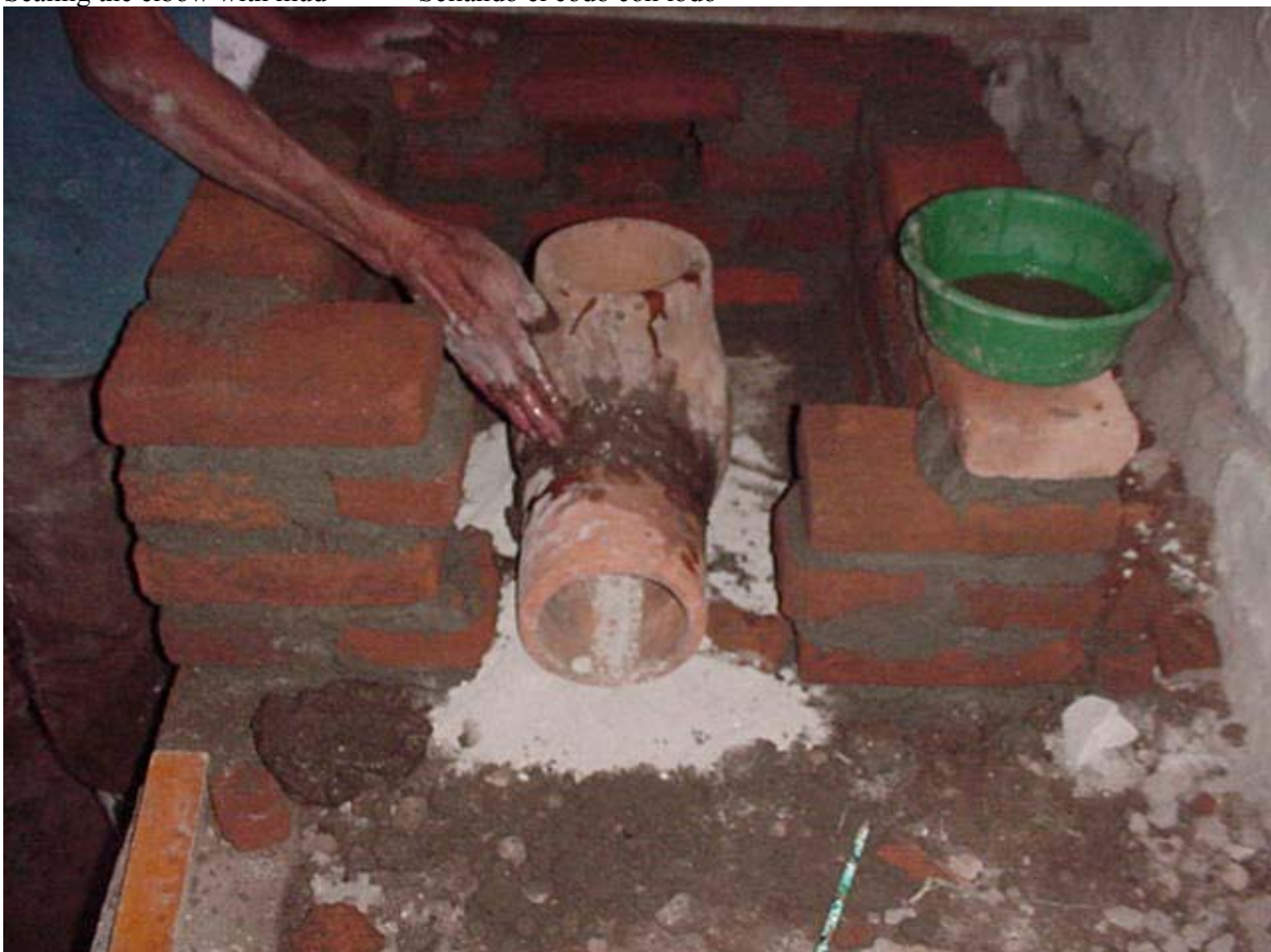
Sealing the elbow with mud Sellando el codo con lodo
